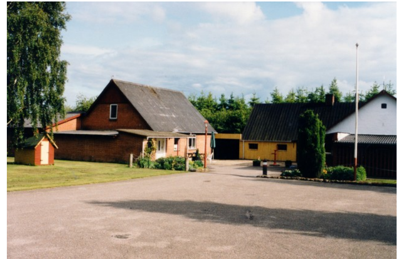
Foto: Funder Barnevognsforretning, Funder Skolevej 17. Ejendommen er nedrevet for at give plads til motorvejen
